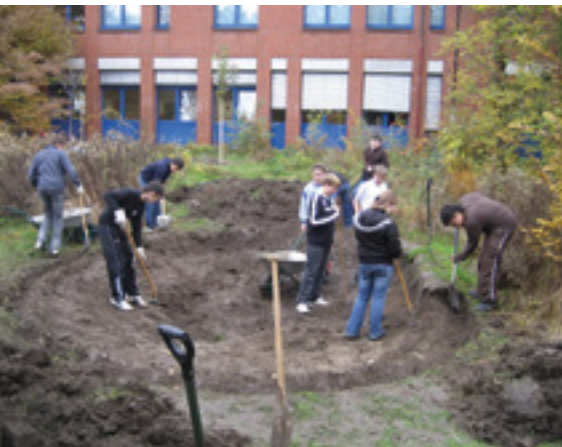
Bau einer Teichanlage an der Gesamtschule Wanne-Eickel.
