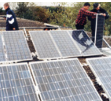
Installation einer Solaranlage auf dem Schuldach.
